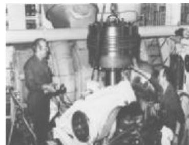
A bord du Gérard LD. Démontage du piston N°4 Au premier plan le culbuteur de la soupape d'échappement de ce cylindre au fond une des deux turbos-soufflantes de suralimentation.
