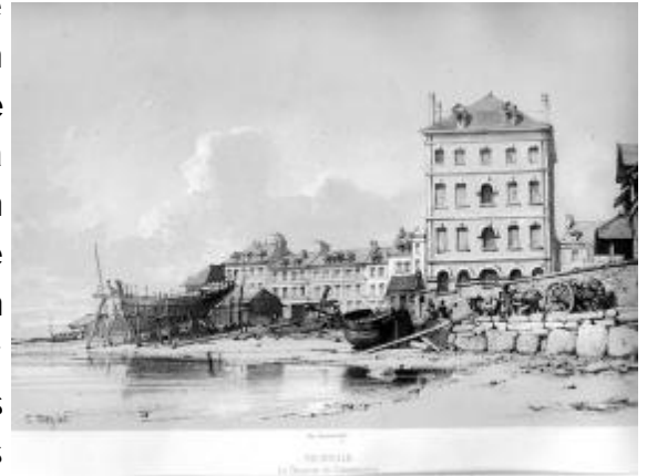
Les chantiers de la Cahotte à l'entrée du port
