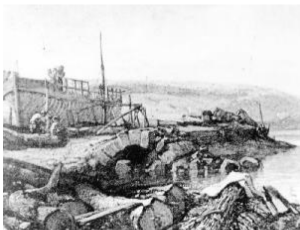
Construction d'une barque chalutière à cul rond à Callenville
