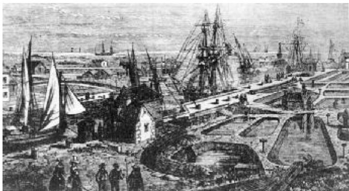
Le chantier Désaunais ,à l'endroit où le s CNR lanceront nombre de navire de pêche en acier dans les années 1960
