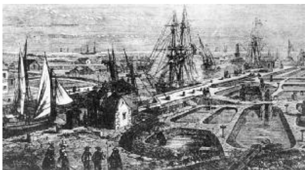
Le chantier Désaunais sur la rive ouest de la Seulle a construit des goélettes, des bricks et des bisquines. L'exiguïté de la rivière ne permettait pas un lancement longitudinal. C'est donc un système de lancement transversal qui était utilisé
