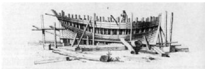
Bisquine en construction au chantier Benoist dessin de Lebreton
