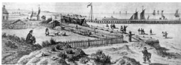
Le chantier Benoist à l'est de la jetée à peu près à l'emplacement de la maison de la Mer actuelle.
